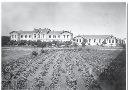
Сградата на болницата, построена през 1902 г.
